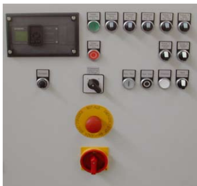
Шкаф управления с типом управления Logo, серийное оборудование.
