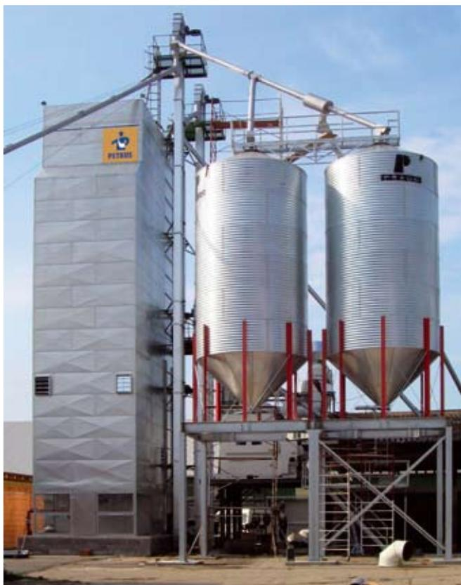
**Зерносушилки PETKUS** – шахтные сушилки непрерывного действия с коробами «шатровой» формы. Зерносушилки PETKUS применимы для семенного, продовольственного зерна, фуража, масличных культур, производительность, к примеру, по пшенице от 5 до 60 т/ч.
